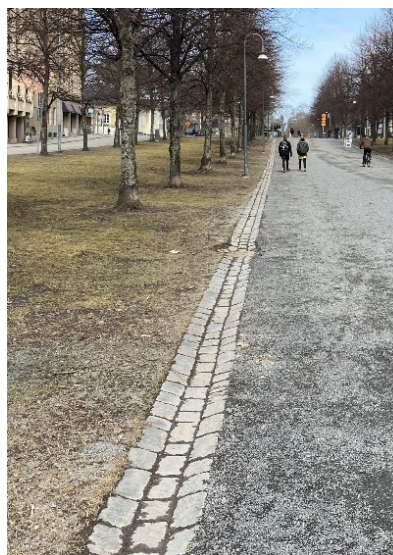
Kuva Hämeenpuiston keskikäytävän kivetystä hulevesikouru (FCG, 2023)
